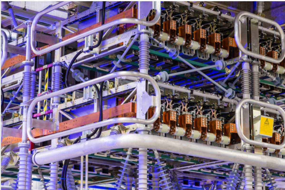
Detailaufnahme eines Konverterturms in HGÜ-Plus-Technik (Quelle: Siemens)
