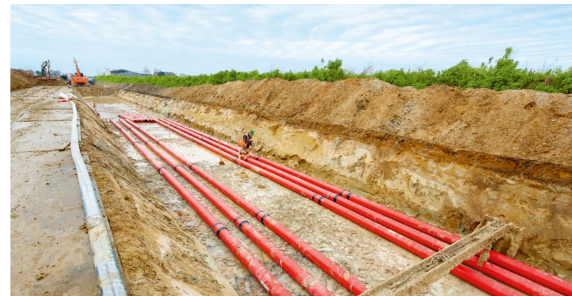
Vergleichbare Wanderbaustelle beim Erdkabel-Pilotprojekt in Raesfeld: Auch die zwei ALEGrO-Kabel werden in Rohre eingezogen. Die Grabensohle für die zwei Kabel ist bei ALEGrO mit anderthalb Metern anstatt fünf Metern jedoch deutlich schmaler.
