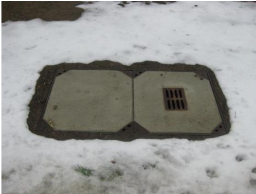
Abbildung 4: Beispiel-Foto eines Unterflurschachts
