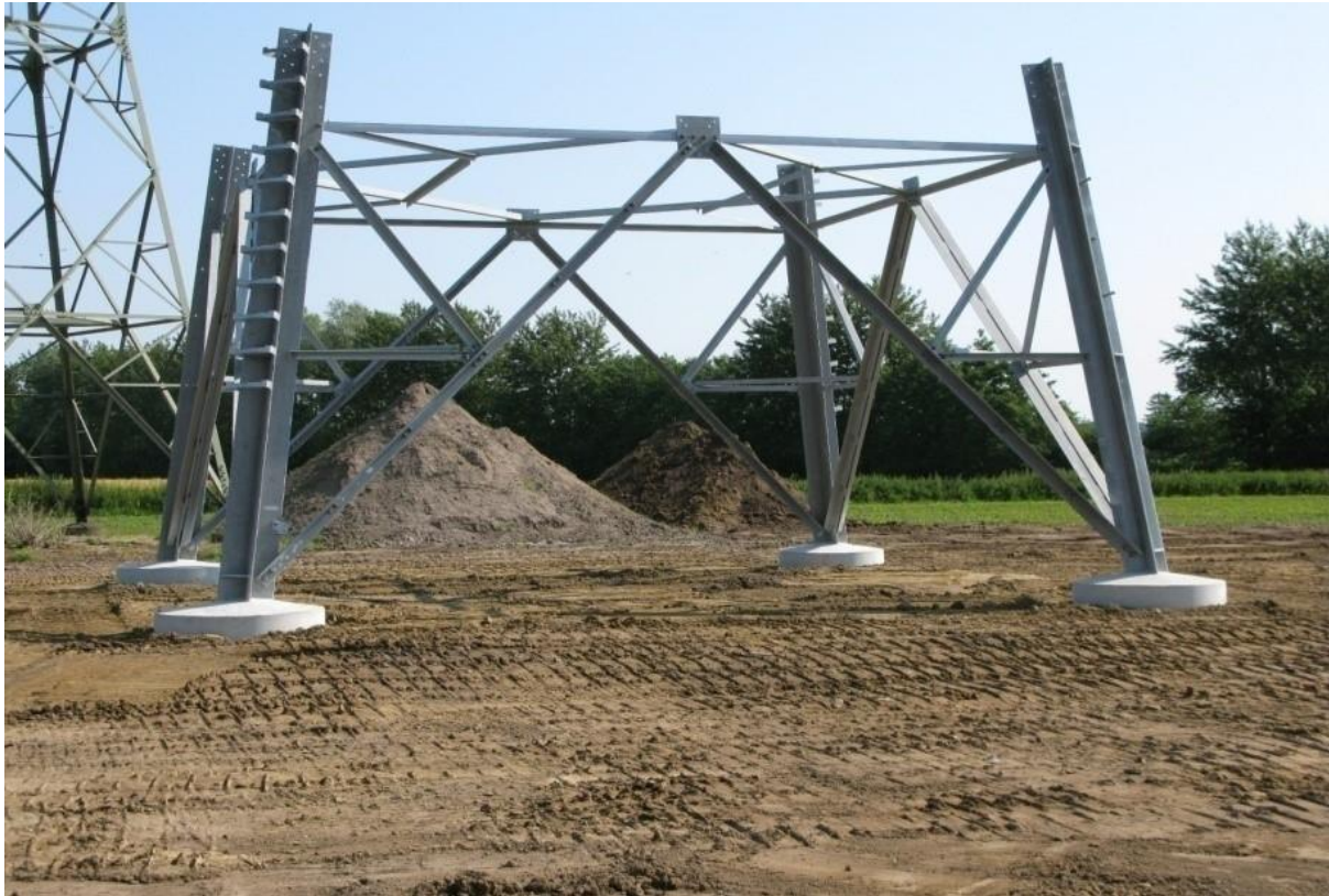
Abbildung 18: Montierter Mastfuß
