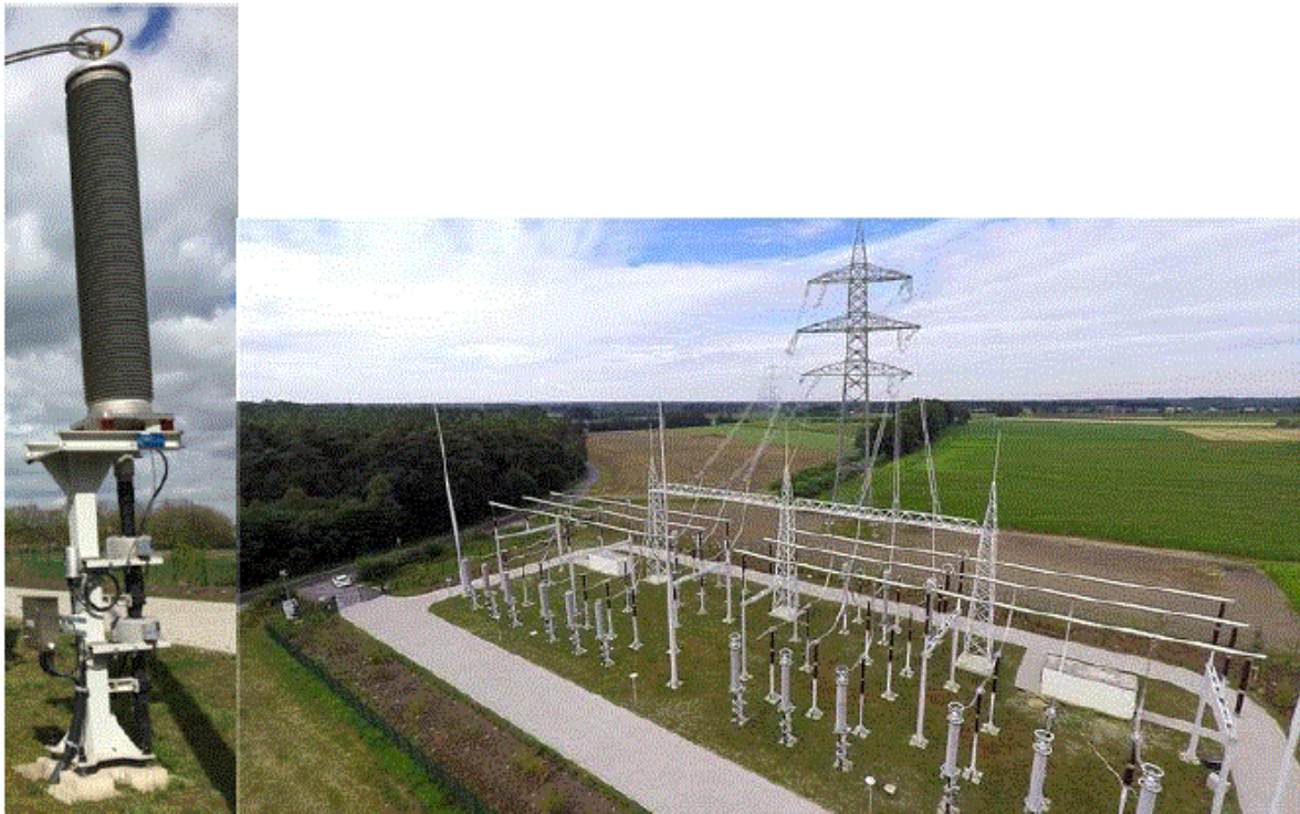
Abbildung 31: Kabelendverschluss und Portal (Beispiel)
