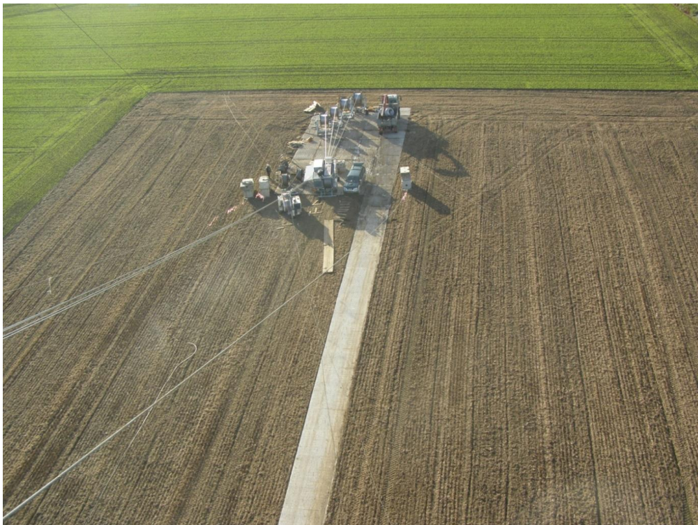
Abbildung 21: Windenplatz eines 4er-Bündel-Seilzuges
