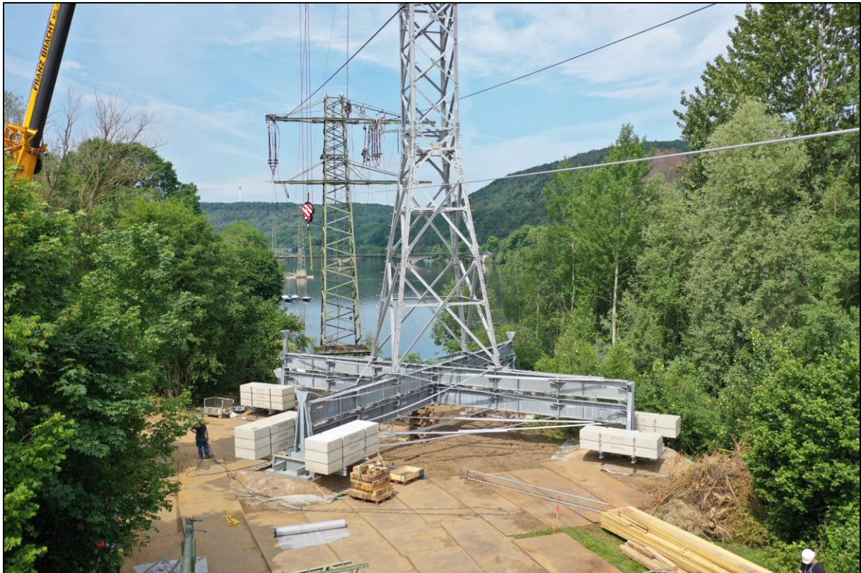
Abbildung 11: Beispiel Auflastfundamente eines Freileitungsprovisoriums
