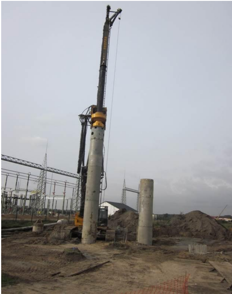
Abbildung 17: Bohrung für einen Bohrpfahl
