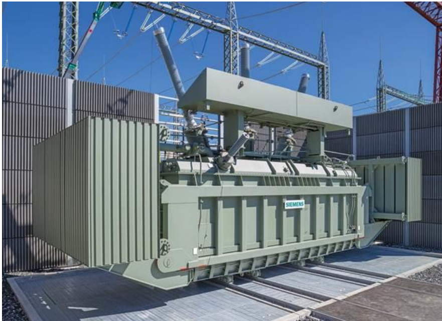
Abbildung 38: Kompensationsanlage Drossel
