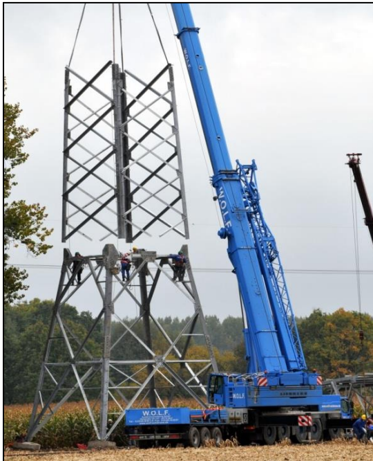
Abbildung 19: Mastmontage (Stocken)
