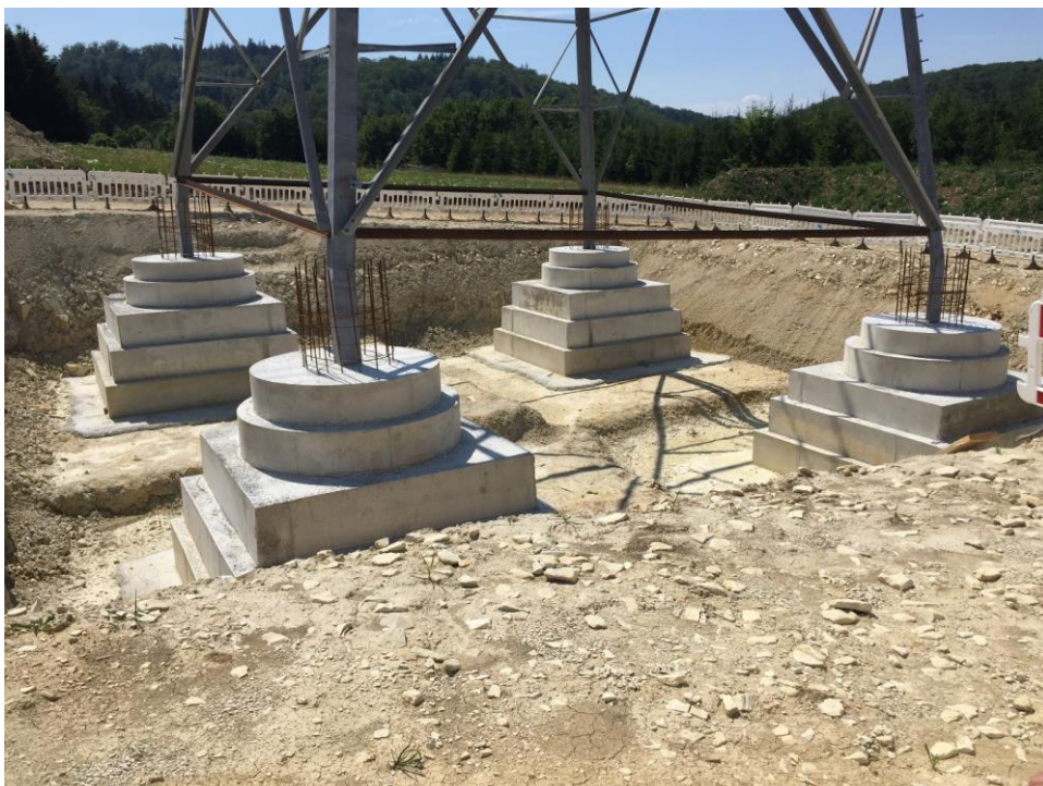
Abbildung 4: Stufenfundament
