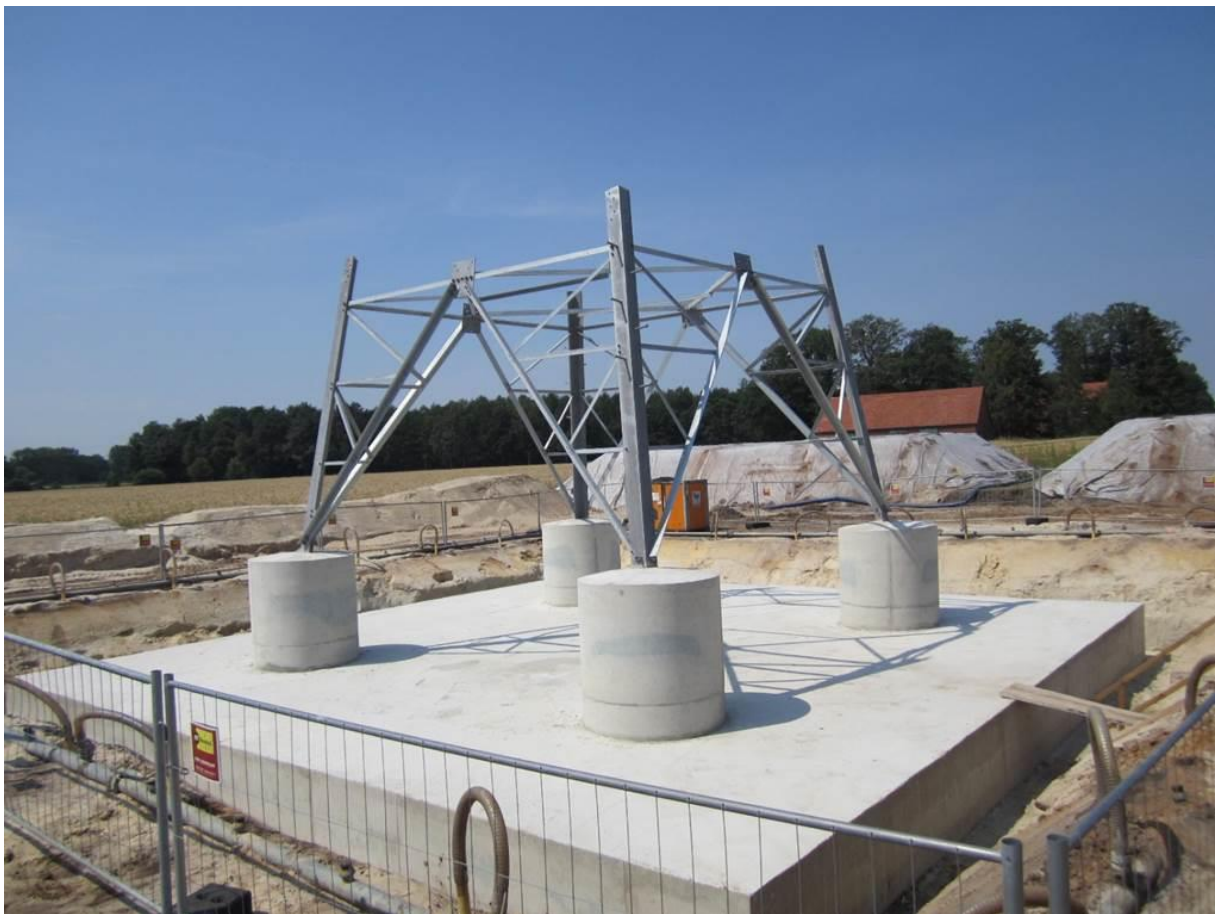
Abbildung 5: Plattenfundament
