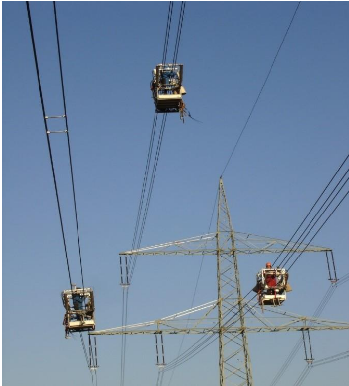
Abbildung 22: Montage der Feldbündelabstandhalter mit Fahrwagen
