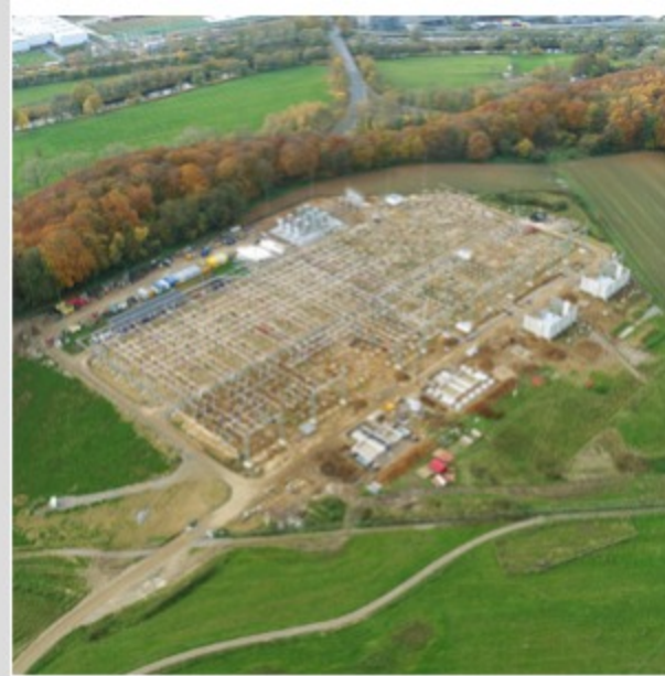
Baustelle Umspannanlage Garenfeld, Foto: Thorsten Milschaltis (Amprion)
