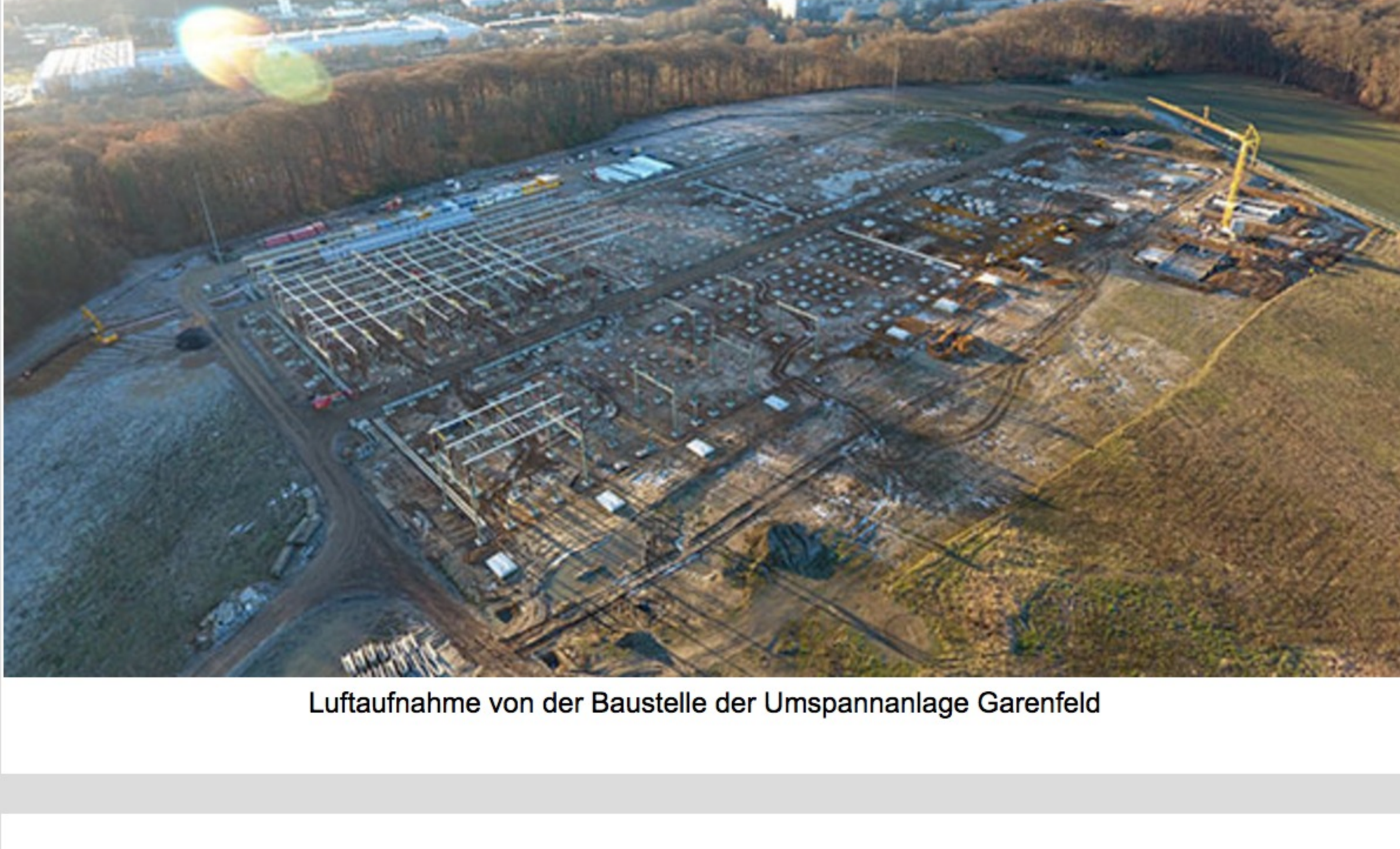
Luftaufnahme von der Baustelle der Umspannanlage Garenfeld
