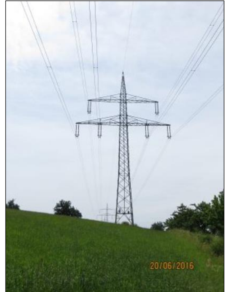
Bl. 2384: Bestandsmast Nr. 5, Standort Trierweiler
