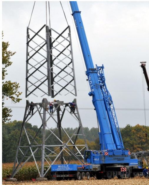
Abb. 49: Mastmontage (Stocken)
