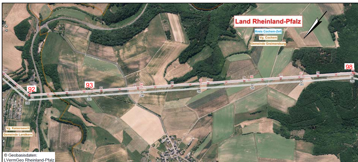
Quelle: Amprion Abb. 24: Luftbild Mast 92 bis 98
