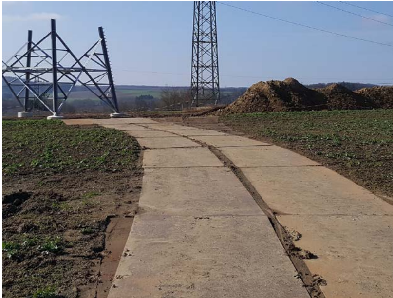
Abb. 44: Temporäre Zuwegung über Fahrbohlen
