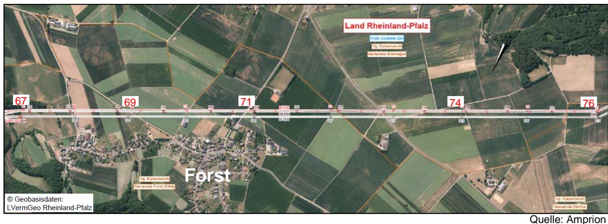
Abb. 20: Luftbild Bereich Forst, Masten 67 bis 76
