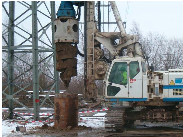
Abb. 42: Bohrung für einen Bohrpfahl
