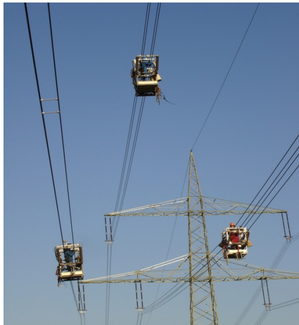
Abb. 53: Montage der Feldbündelabstandhalter mit Fahrwagen
