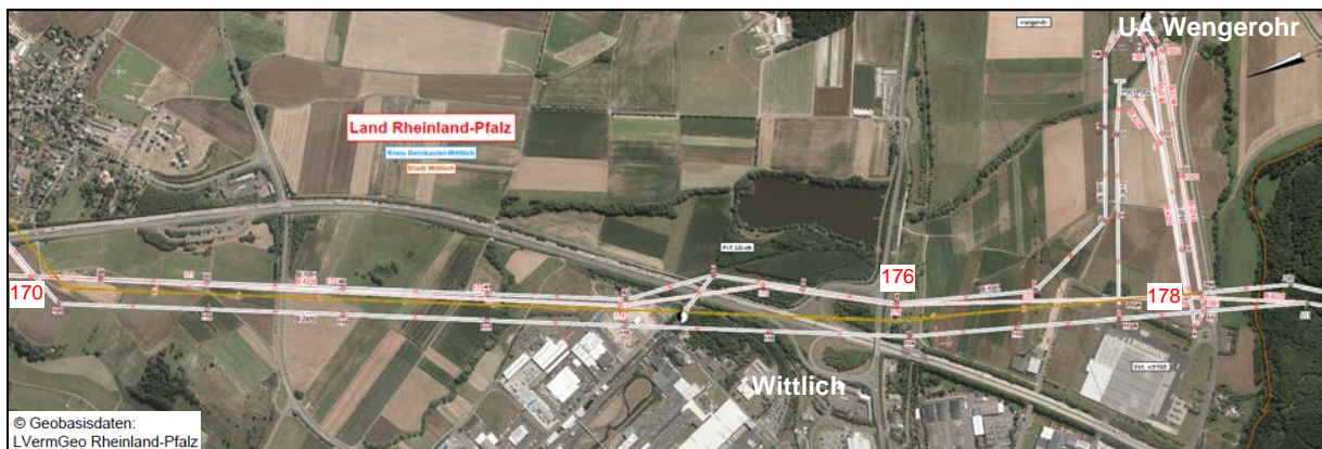
Abb. 40: Luftbild Masten 170 – 178 / UA Wengerohr
