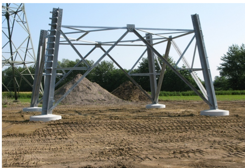
Abb. 48: Montierter Mastfuß
