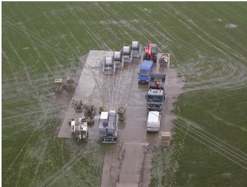
Abb. 52: Windenplatz eines 4er-Bündel-Seilzuges
