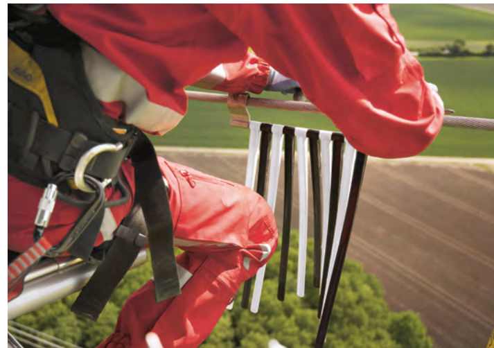
Die schwarz-weißen Vogelschutzmarkierungen werden mithilfe eines Hubschraubers am Erdseil montiert. Das schlecht sichtbare Seil ist für Vögel so besser erkennbar.
