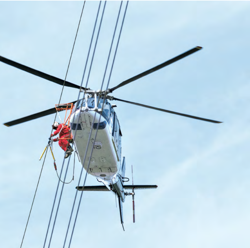
Die schwarz-weißen Vogelschutzmarkierungen werden mithilfe eines Hubschraubers am Erdseil montiert. Das schlecht sichtbare Seil ist für Vögel so besser erkennbar.
