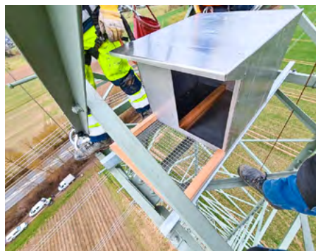
Die neuen Nistkastenmodelle für verschiedene Falkenarten lassen sich besonders sicher an den Freileitungsmasten montieren und haben eine hohe Langlebigkeit.
