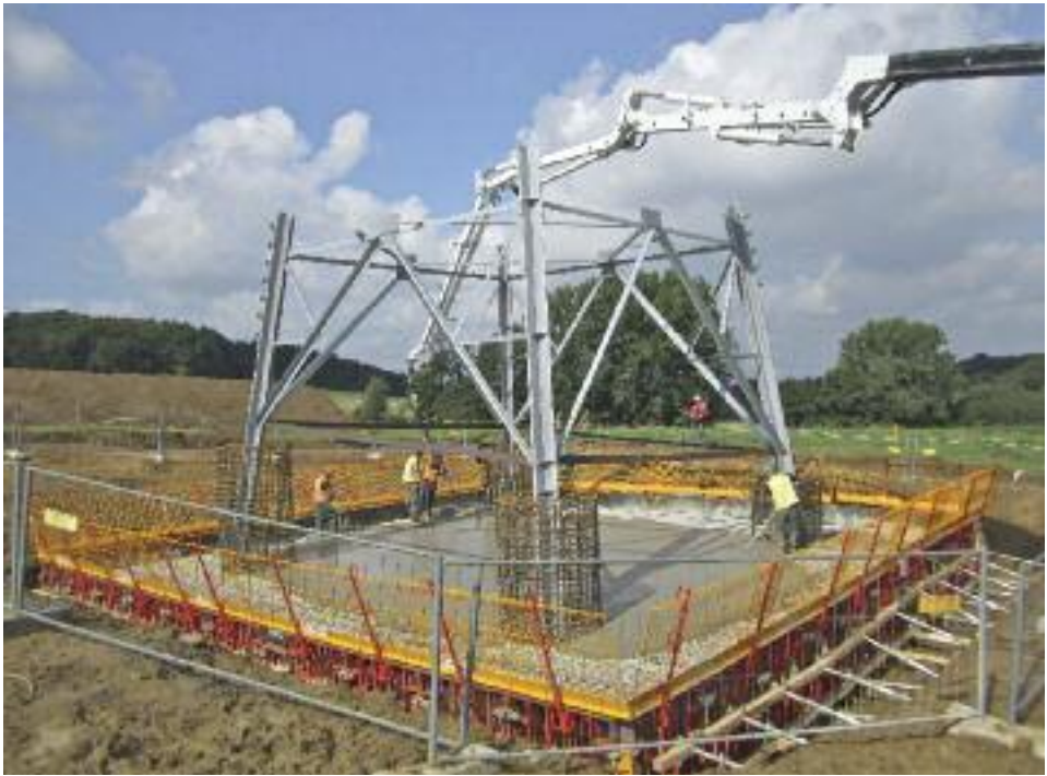
Abb. 2 und 3: Gründung von Mastfundamenten (Fotos: Amprion).
