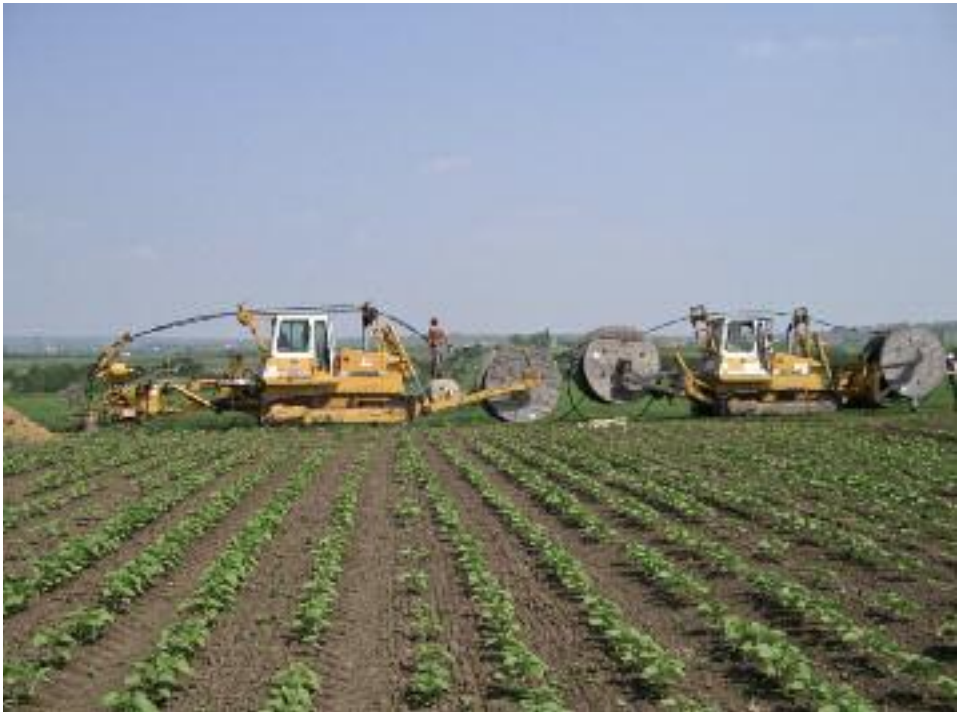
Abb. 4: Erdverkabelung einer Mittelspannungsleitung der EVN (mittlerweile Netz Niederösterreich GmbH) im Projekt – Teilgebiet Westliches Weinviertel (Foto: Sylvia Raab).
