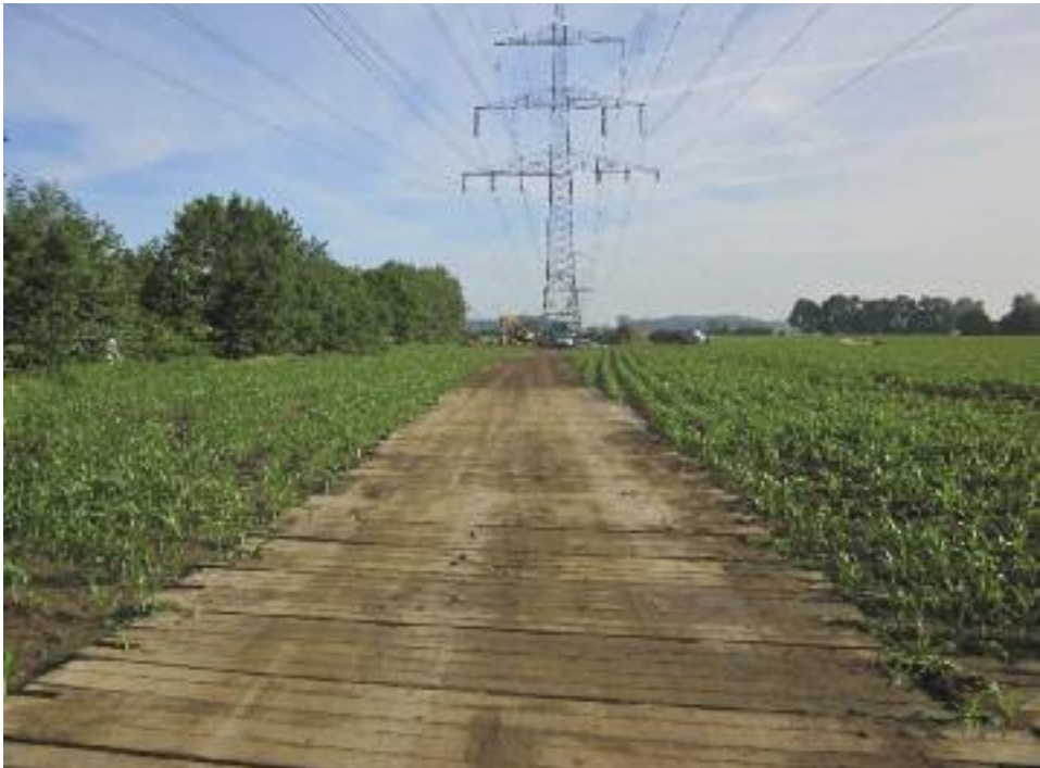
Abb. 1: Errichtung von Zuwegungen (Foto: Amprion).
