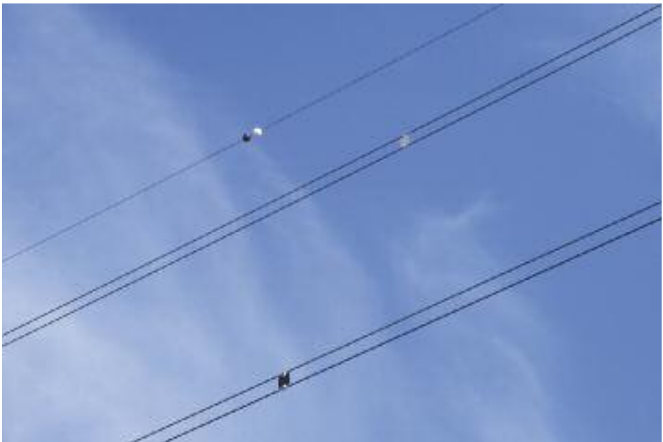
Abb. 10: Mit Vogelwarnkugeln bzw. -tafeln markierte Hochspannungsleitungen der APG im Projekt – Teilgebiet Parndorfer Platte – Heideboden (Foto: Rainer Raab).
