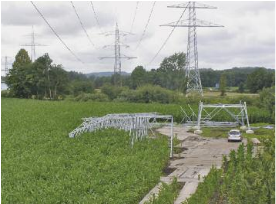
Abb. 4 und 5: Mastmontage (Fotos: Amprion).
