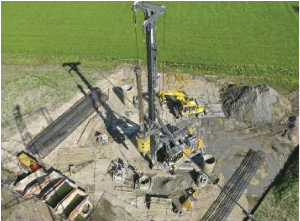
Abb. 2 und 3: Gründung von Mastfundamenten (Fotos: Amprion).
