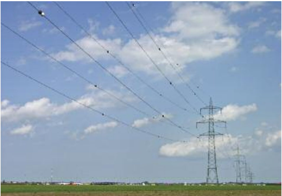
Abb. 11: Mit Vogelwarnkugeln markierte Hochspannungsleitungen der APG im Projekt – Teilgebiet Parndorfer Platte – Heideboden (Foto: Rainer Raab).
