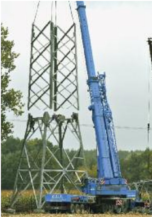
Abb. 4 und 5: Mastmontage (Fotos: Amprion).
