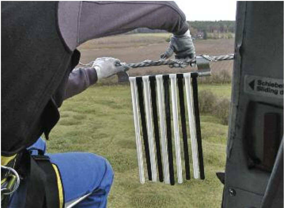
Abb. 9: Vogelschutzmarkierung aus schwarz-weißen beweglichen Kunststoffstäben der Firma RIBE (Foto: Amprion).
