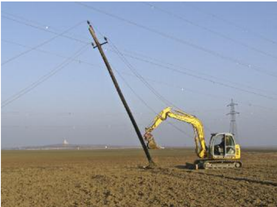
Abb. 6: Erdverkabelung und anschließender Abbau einer Mittelspannungsleitung der EVN (mittlerweile Netz Niederösterreich GmbH) im Projekt – Teilgebiet Westliches Weinviertel (Foto: EVN).
