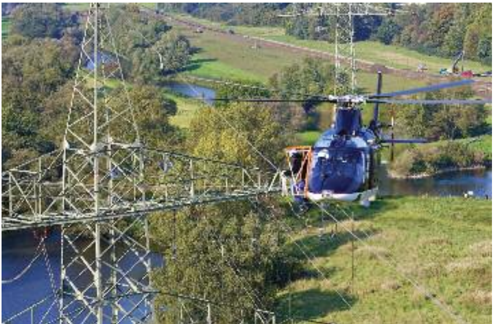
Abb. 12: Vogelschutzmarkierung mit dem Hubschrauber (Foto: Westnetz GmbH).
