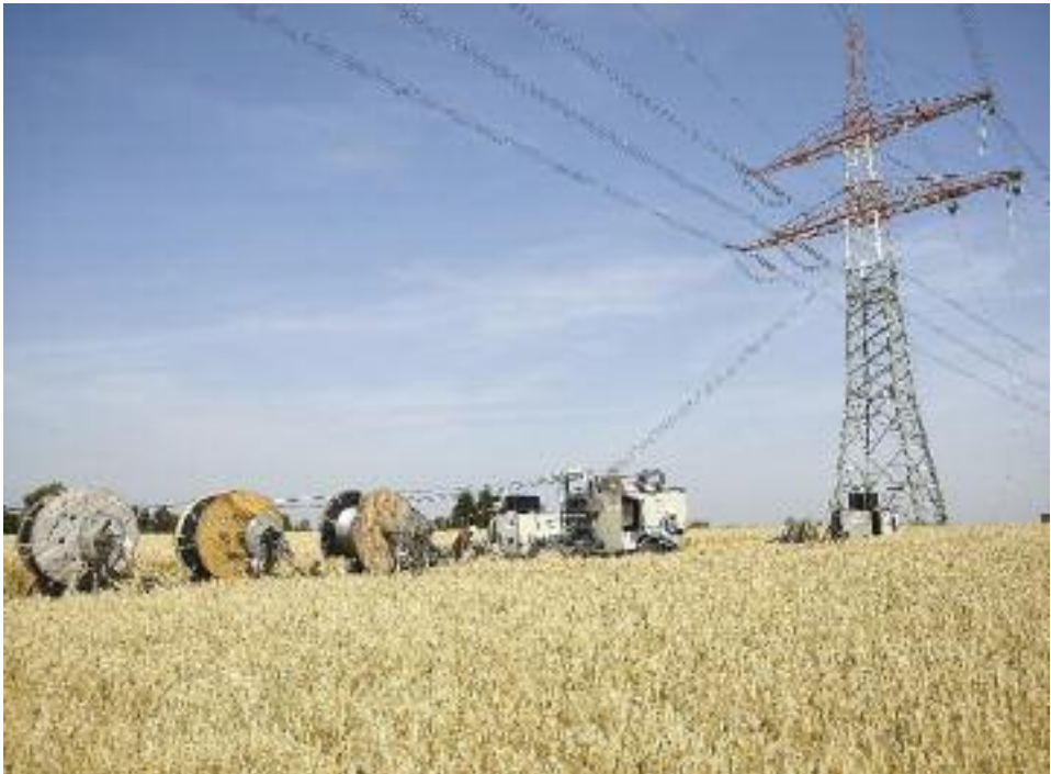
Abb. 6: Seilzug (Foto: Amprion).
