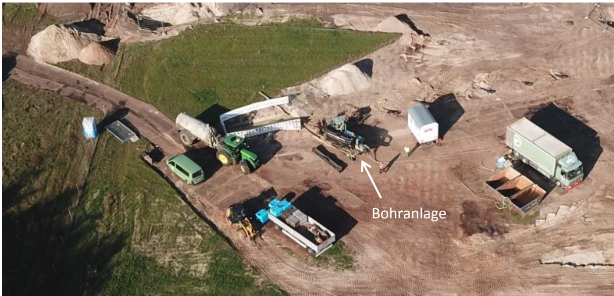
Abbildung 9: Baustelleneinrichtung Spülbohrverfahren HDD
