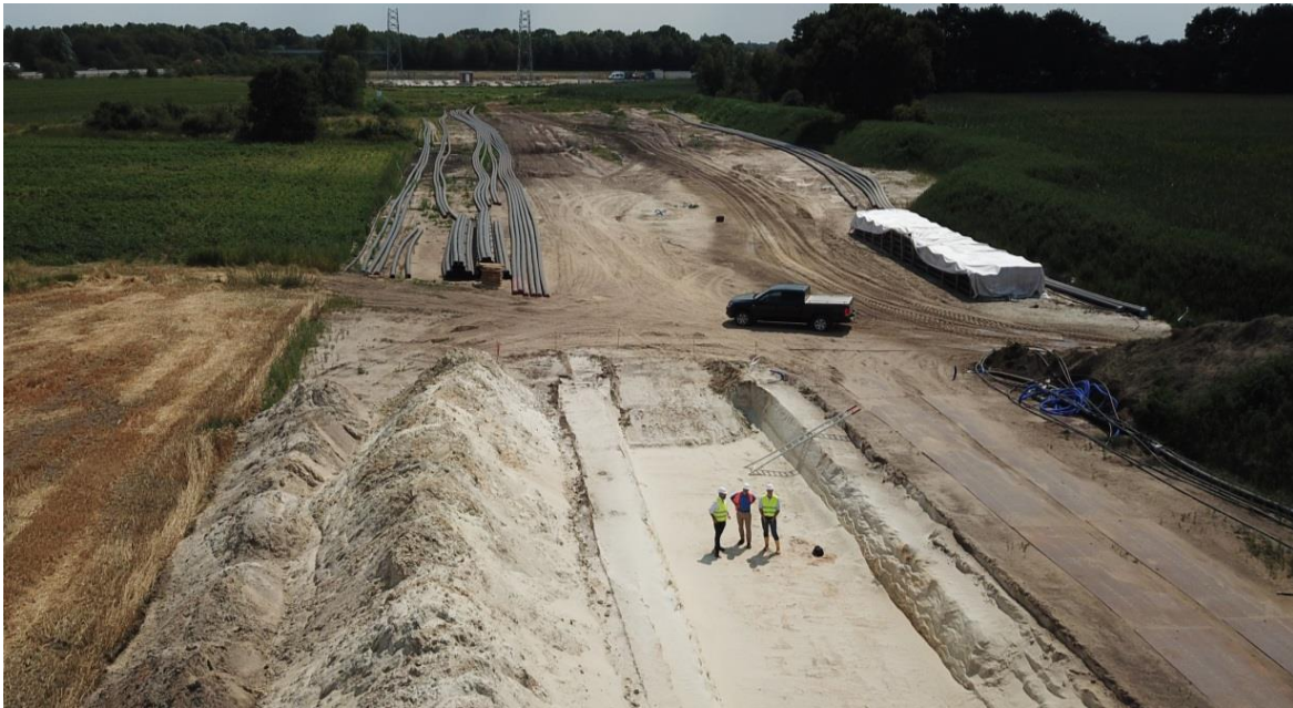
Abbildung 4: Offener Erdkabelgraben im Projekt Dörpen - Niederrhein (TenneT) Im Hintergrund sind die Leerrohre für die spätere Verlegung im Graben zu sehen.
