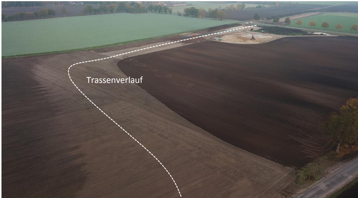
Abbildung 6: Rückverfüllter Erdkabelgraben nach Verlegung der Leerrohre und Wiedereinbau des Bodens
