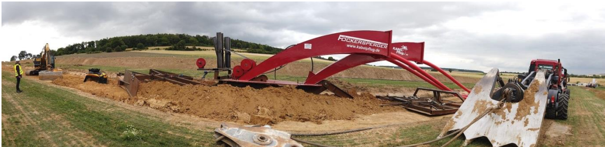
Abbildung 11: Erprobung der Verlegung von 380-kV-Erdkabeln mit dem Kabelpflug bei Hildesheim
