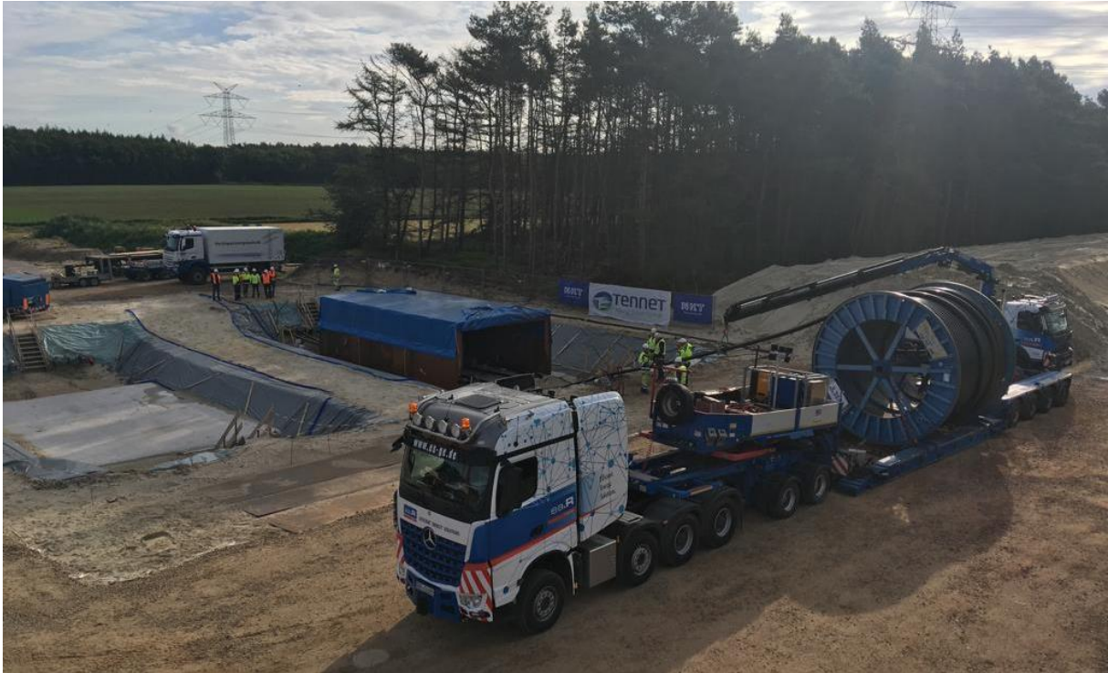
Abbildung 7: Erdkabeleinzug vom Tieflader an einer Muffengrube
